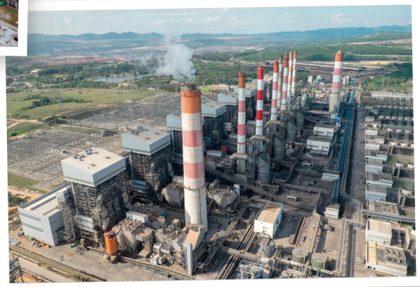
รูปที่ 29 โรงไฟฟ้าแม่เมาะ จ.ลำปาง
