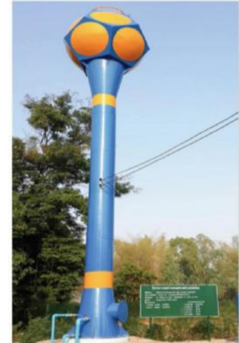
หอเก็บน้ำสำหรับส่งน้ำไปยังครัวเรือน
