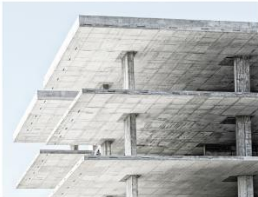
ก. พื้นอาคาร
