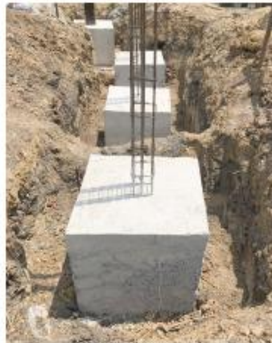
ข. เสารองรับอาคาร
