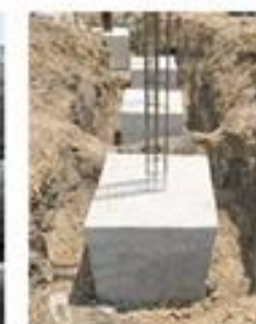
ข. เสารองรับอาคาร
