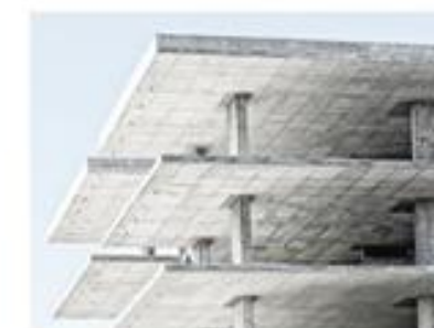
ก. พื้นอาคาร
