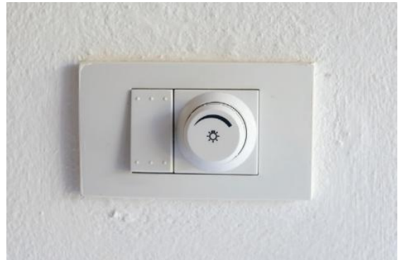
ก. ปุ่มปรับความดังของเสียงในเครื่องเสียง ข. ปุ่มปรับความสว่างในวงจรหรี่ไฟ ภาพที่ 5 ตัวอย่างการใช้งานตัวต้านทานแปรค่าได้ในชีวิตประจำวัน
