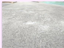
คอนกรีต
