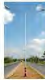
เสาไฟถนนสูง 6 ม. 50 ซม.
