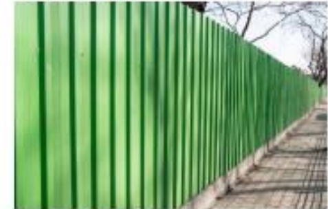
ภาพที่ 1 รั้วเหล็กทาสีเพื่อป้องกันการเกิดสนิม
