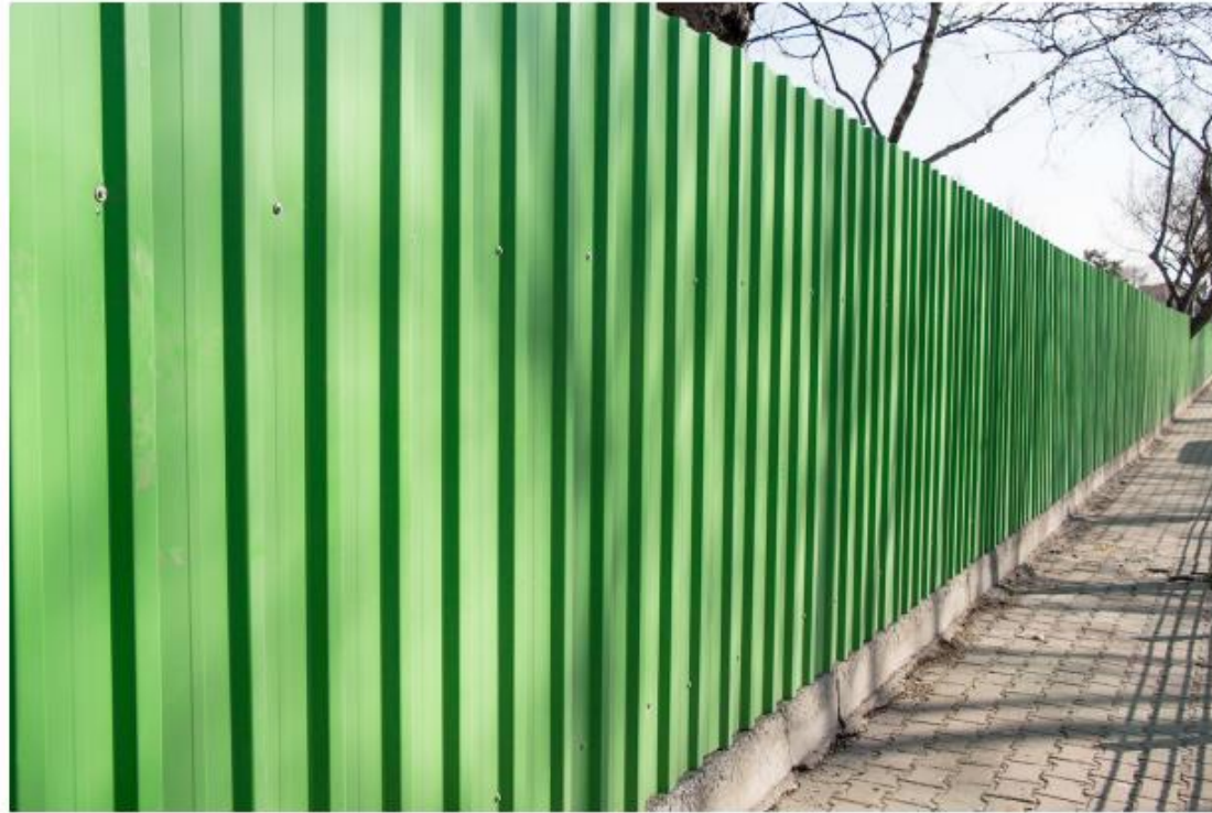
ภาพที่ 1 รวเหล็กทาสีเพื่อป้องกันการเกิดสนิม
