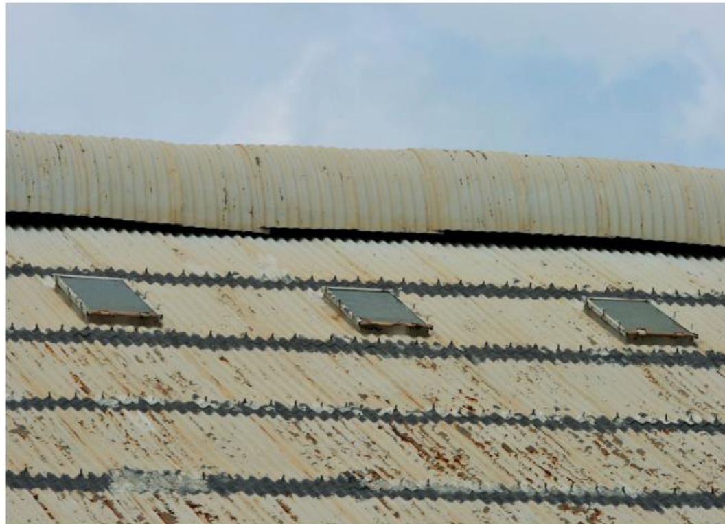
ภาพที่ 2 การผุกร่อนของหลังคาสังกะสีเมื่อทำปฏิกิริยากับฝนที่มีสมบัติเป็นกรด
