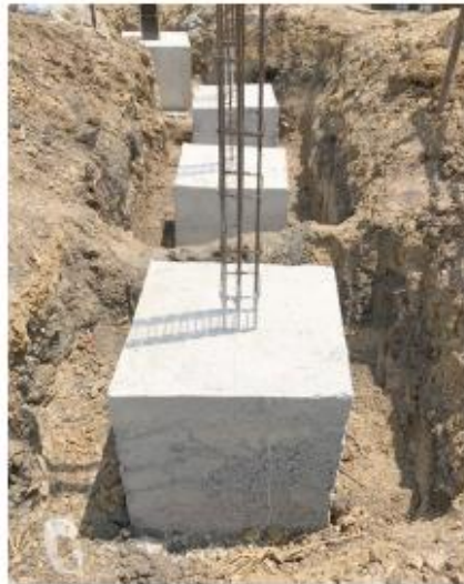
ข. เสารองรับอาคาร
