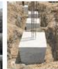
ข. เสารองรับอาคาร
