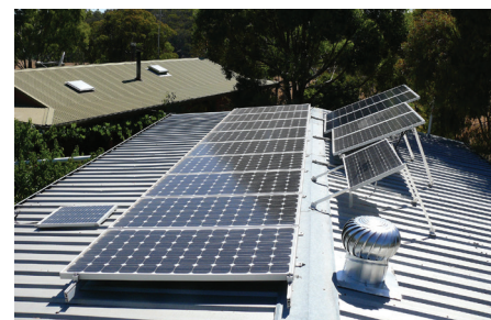
ฉ. หลังคาของอาคารต่าง ๆ
