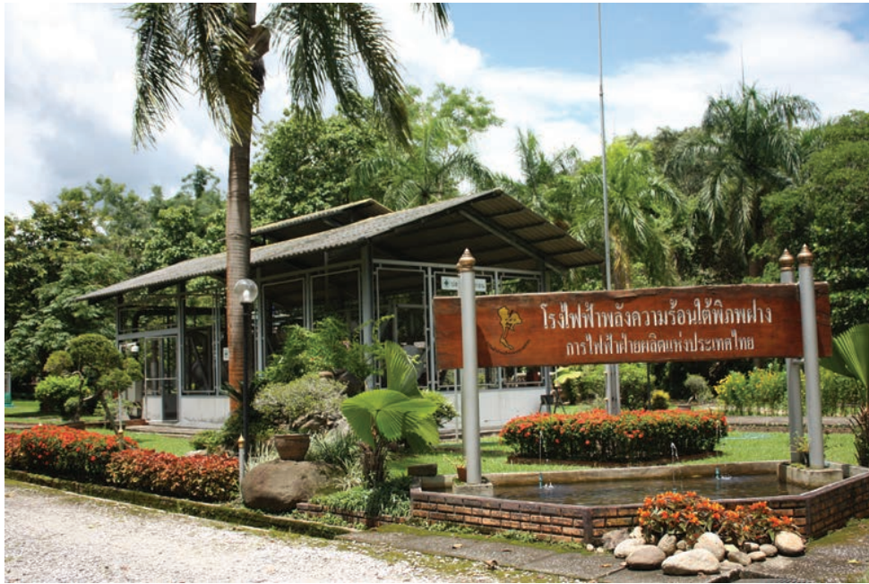
ภาพที่ 18 โรงไฟฟ้าพลังงานความร้อนใต้พิภพฝาง จังหวัดเชียงใหม่
