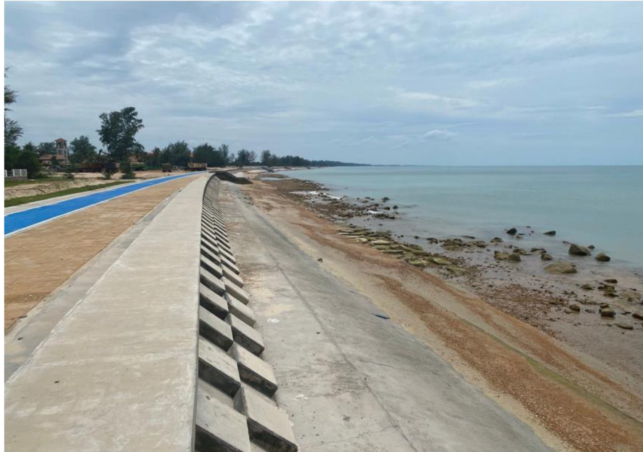
ภาพที่ 9 โครงสร้างป้องกันการกัดเซาะชายฝั่ง เชื้อนป้องกันตลิ่งริมทะเล ตำบลชิงโค อำเภอสิงหนคร จังหวัดสงขลา ที่มา : กรมทรัพยากรทางทะเลและชายฝั่ง
