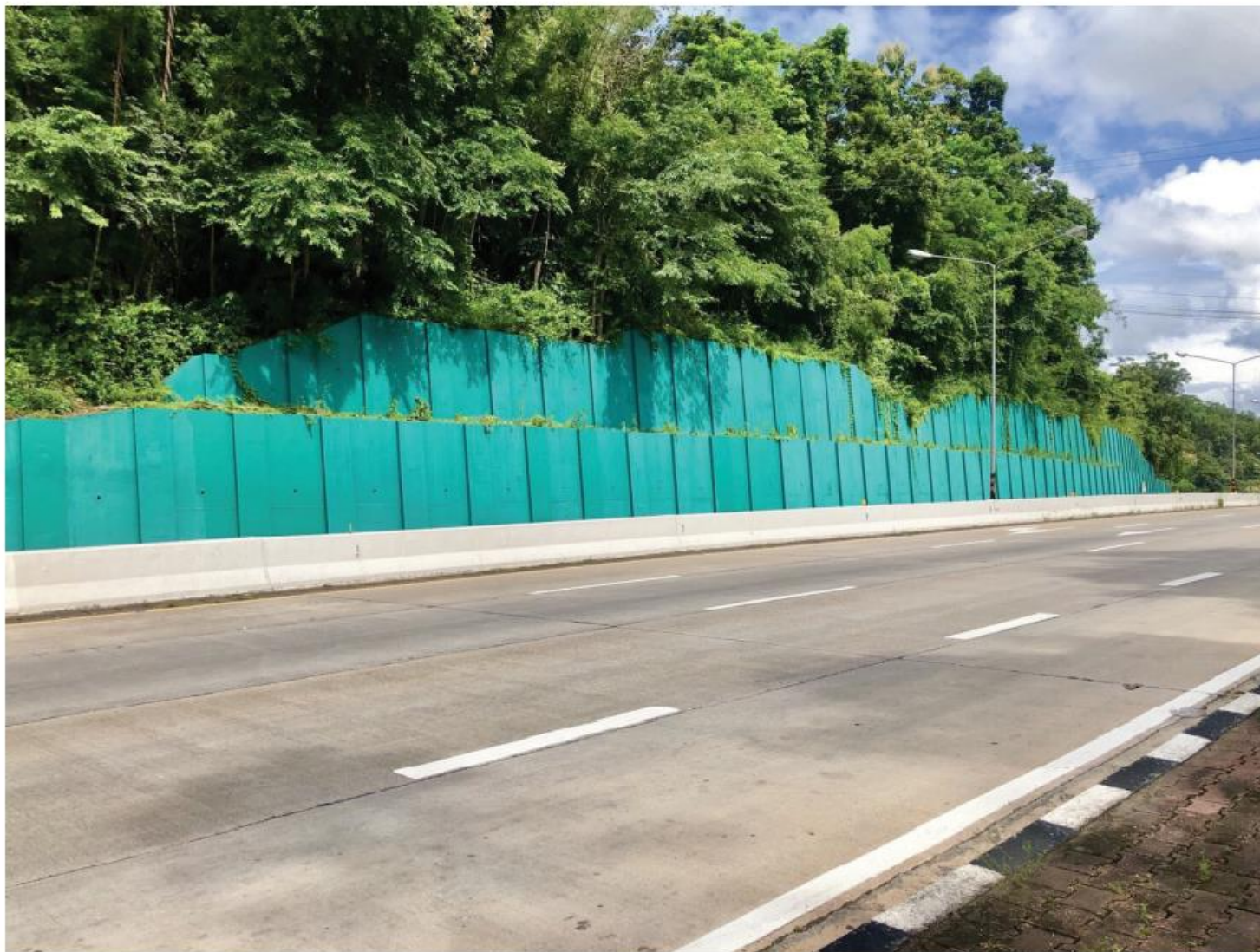
ภาพที่ 5 การทำกำแพงคอนกรีตป้องกันแผ่นดินถล่ม
