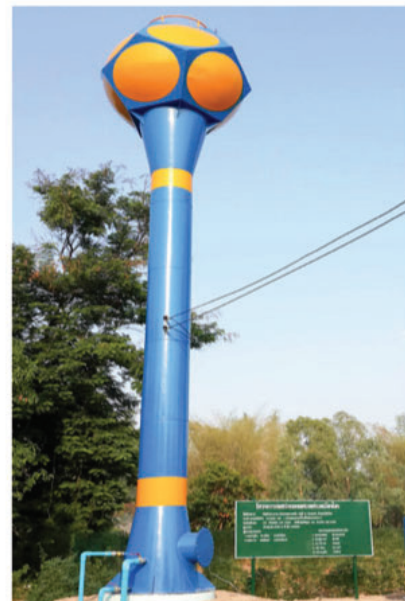
หอเก็บน้ำสำหรับส่งน้ำไปยังครัวเรือน
