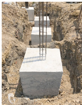
ข. เสารองรับอาคาร
