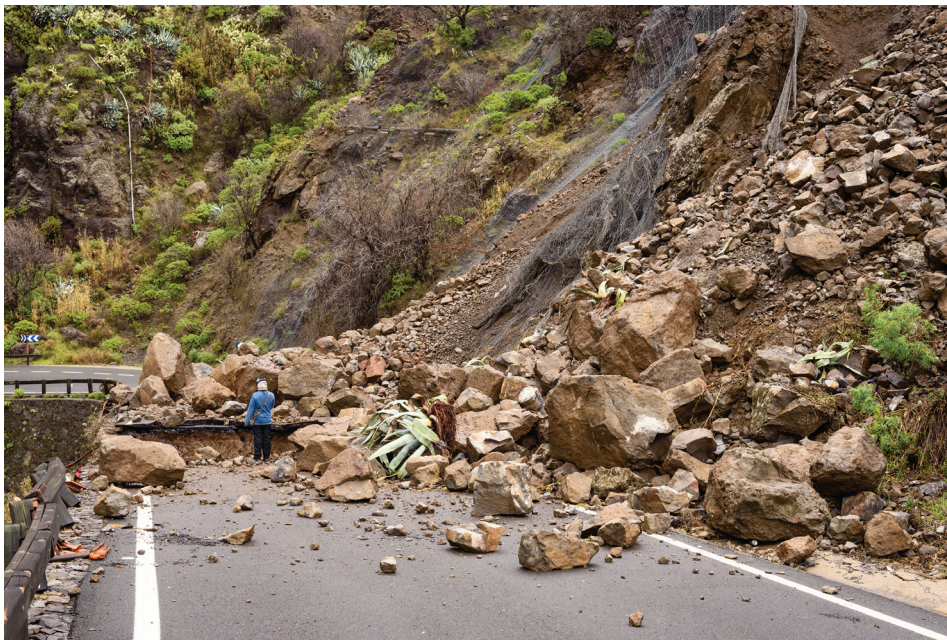
ภาพที่ 4 การถล่มลงมาของดินและหินร่วมกันตรงบริเวณทีลาดเชิงเขา
