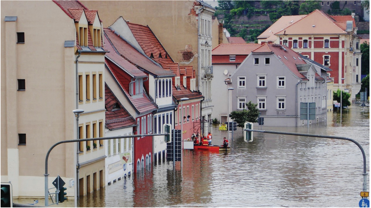
จ. น้ำท่วมขังในเขตที่พักออาศัย
