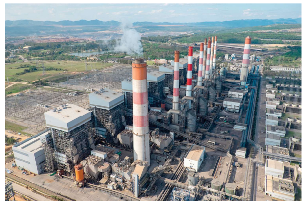
รูปที่ ๓๐ โรงไฟฟ้าแม่เมาะ จ.ลำปาง ที่ใช้ถ่านหินผลิตไฟฟ้า
