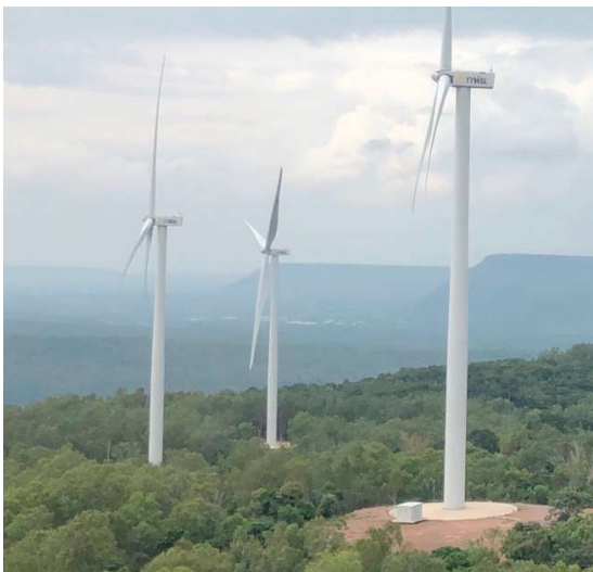
รูปที่ ๓๑ กังหันลมลำตะคอง จ.นครราชสีมา ใช้พลังงานลมในการผลิตไฟฟ้า
